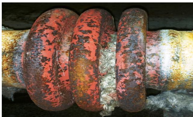
Рис. 1. Линзовый компенсатор
