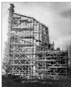
Строительство главного корпуса КазГЭС (ТЭЦ-1), Казань, 1930 г. ИМ РТ
