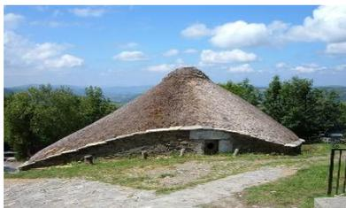
сооружения в Испании. У такого дома каменные стены, крыша из соломы на деревянном каркасе, примерная высота 4-5 метров. Пальосы строились в средневековье, а сейчас это историческое
