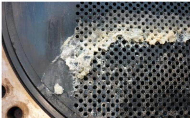
Рис.3.2. Отложения в сырьевом теплообменнике Т-201 установки ЛЧ-24/7, остановленного на ремонт по причине наличия хлорсодержащих примесей в сырье
