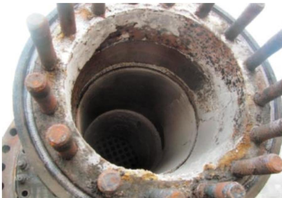
Рисунок 1.4 – Отложения в сырьевом теплообменнике Т-1/1 установки Л-35/11 (ремонт 2013 г.) Причина – наличие хлорсодержащих примесей в нефтяном сырье, поступающем в установку [72]
