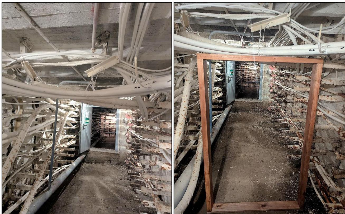
Рисунок 5.2 – Установка подпорной рамы под кабели
