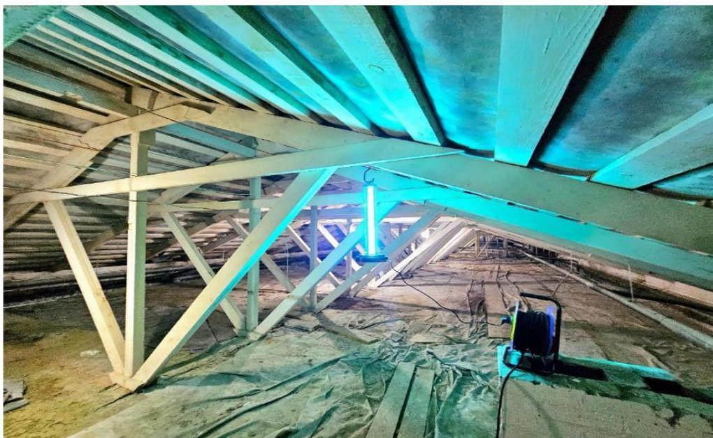
Рисунок 5.8б – Практическое применение ультрафиолетовой лампы для обработки поверхности
