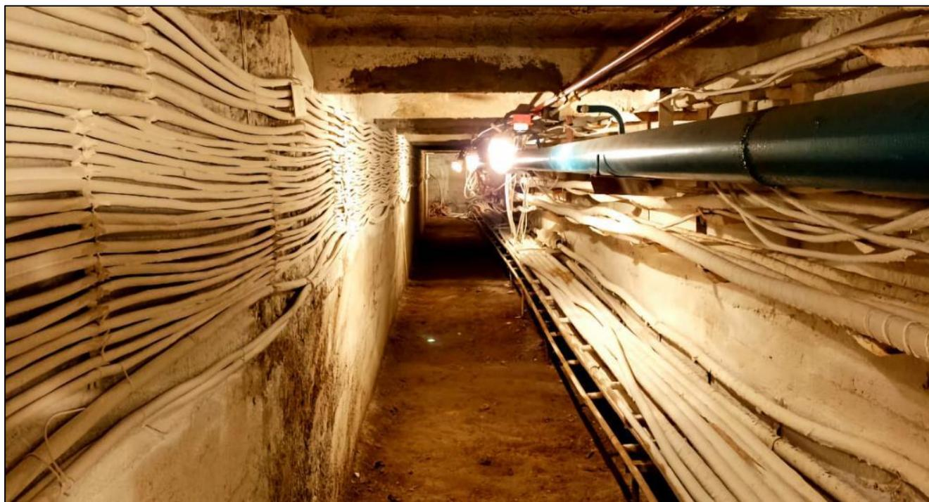
Рисунок 5.7 – Фото кабельного канала после нанесения огнезащитного состава
